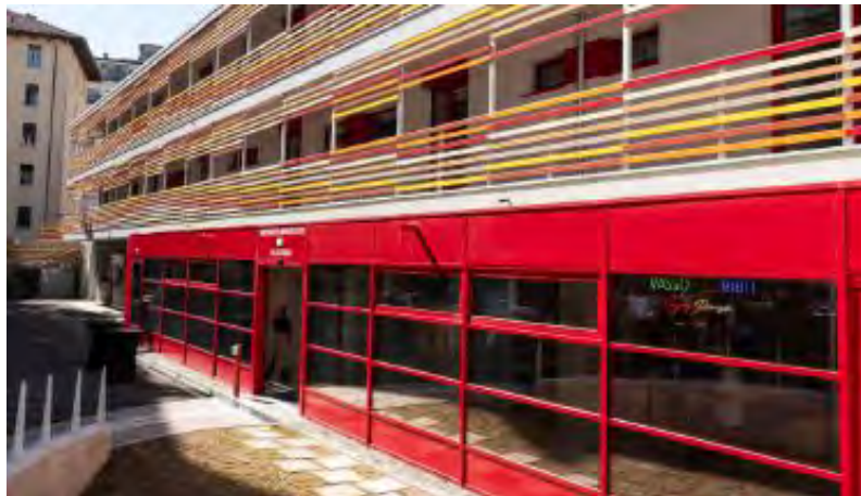
Residenza La struttura è costruita con particolare attenzione a livello ambientale, senza l'utilizzo di fonti fossili, con impianti di recupero dell'acqua per i wc e con pannelli solari (Foto Ghisu)
