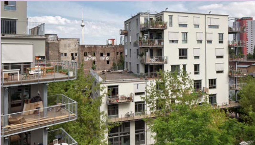
Fig. 4. Coop Housing at River Spreefeld, by Carpaneto Architekten + Fatkoehl Architekten + BARarchitekten (2013 ca.). © Ute Zscharnt.
