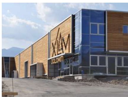
1. Sede produttiva di pannelli X-Lam, Castelnuovo Valsugana, 2010/12 Studio Arcatop (Aldo Tomaselli, Licia Pirazzi), Pierluigi Coradello
