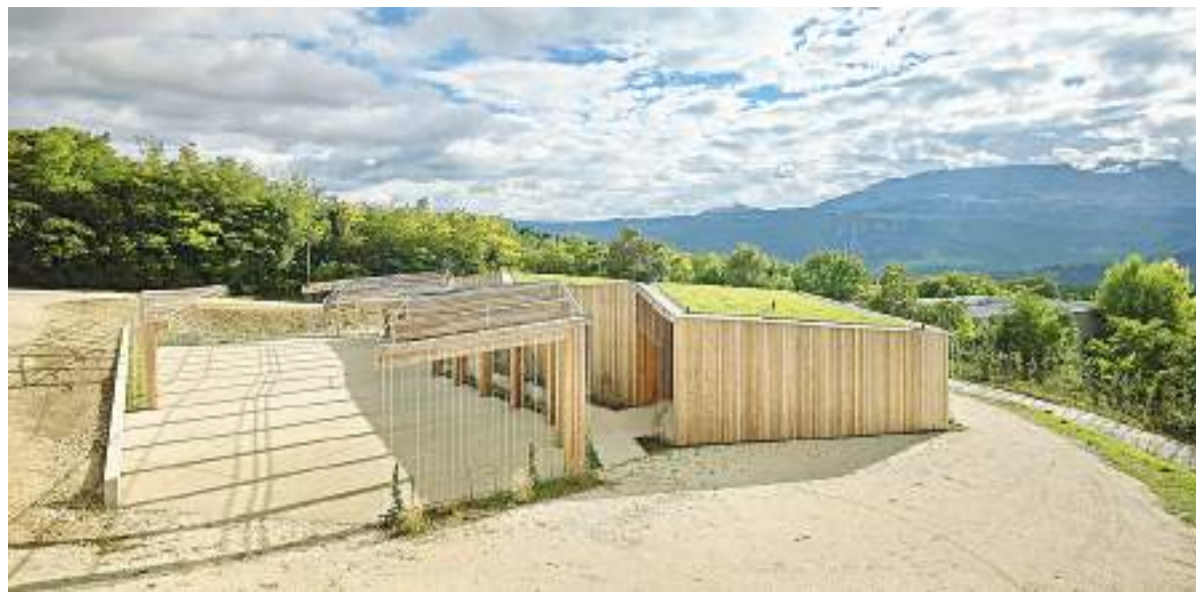
Dopo il terremoto Il Centro d'aggregazione giovani e anziani realizzato a Poggio Picenze, a quindici chilometri da L'Aquila
