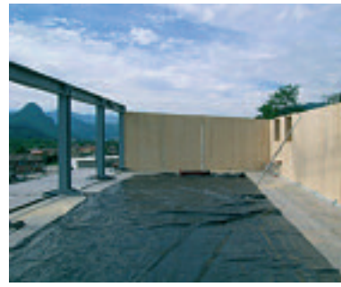
La trave Vierendeel e i pannelli prefabbricati in legno.
