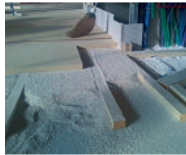
Interni dell'edificio in costruzione: a destra i massetti a secco.
