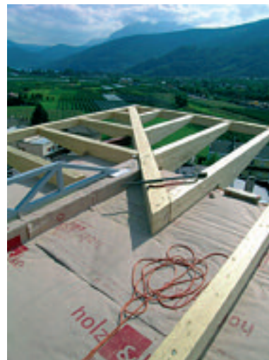
Dettagli della orditura delle travi del tetto.
