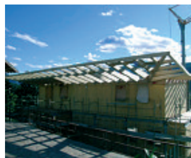
Viste del fabbricato in costruzione.
