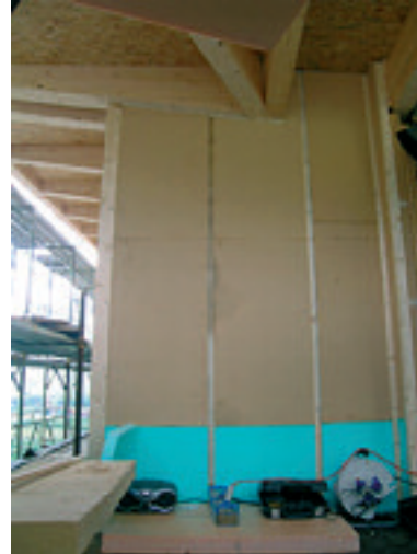
Particolari della struttura.
